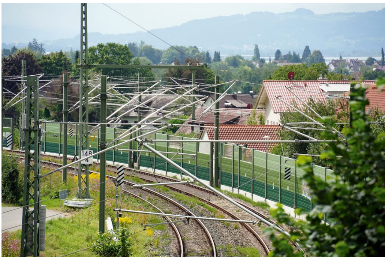
Lärmschutzwände in Bodolz/Bayern
