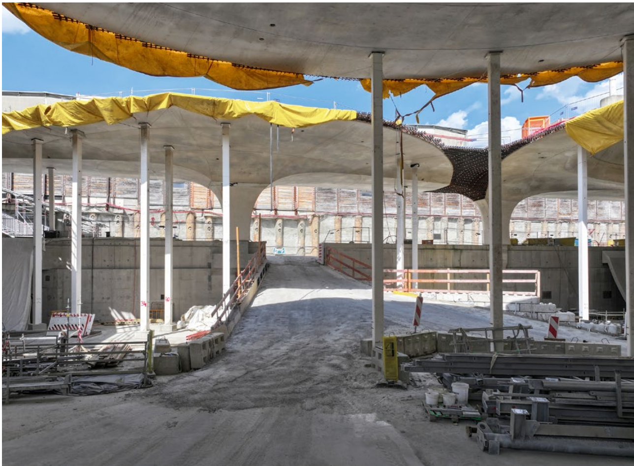
Bau des Durchgangsbahnhofs in Stuttgart
