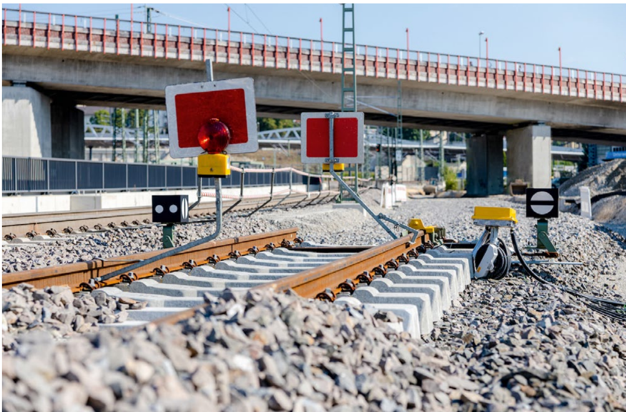
Bau am Bahnhof Ulm, Quelle: DB AG/Thomas Kiewning
