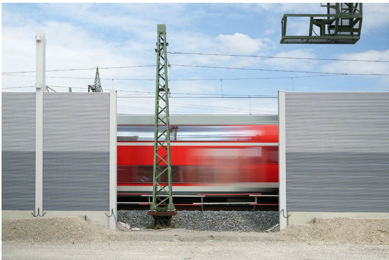
Bau von Lärmschutzwänden in Forchheim
